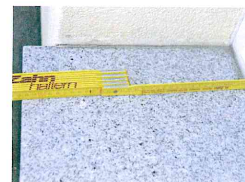
Tiefe der Fensterbank mit elastischer Fuge Fotos: Harald Zahn
